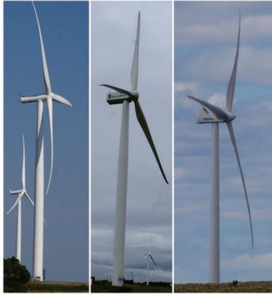
Fig. 2. a) Siemens SWT 2.3 MW b) Sinovel SL3000/113-HH90 c) Vestas V100-1.8 MW.
